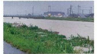
8月 城原川新宿橋 大雨増水
