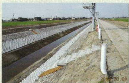
平成26年3月9日 クレーク防災工事(神埼町)
