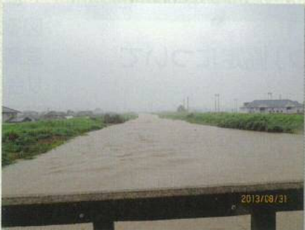
平成25年8月31日 城原川大雨増水 (新宿橋付近)
